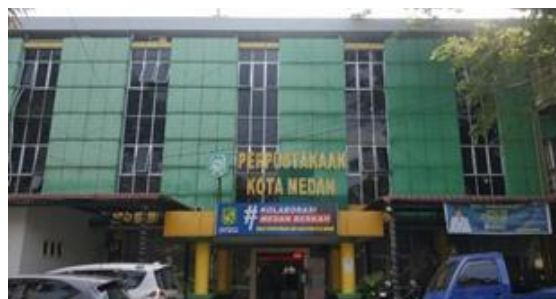
Gambar 1. Tampak Fasad Gedung Perpustakaan Dan Kearsipan Kota Medan (Sumber: Data Pribadi, 2024)
